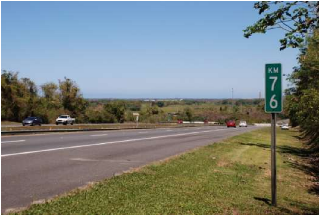
Figura B-10a. Punto de Observación Clave 7 - Vista hacia el este desde la Carretera PR-22
