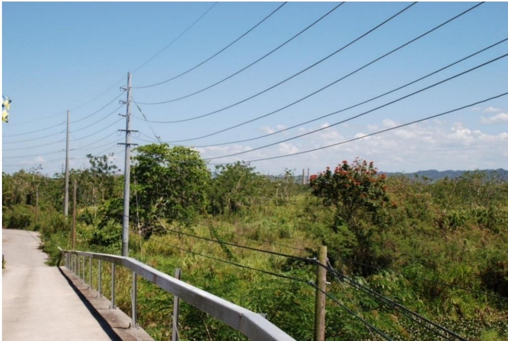
Figura B-7a. Punto de Observación Clave 4 - Vista del Proyecto hacia el sureste fuera de PR-2, antes de cruzar el Río Grande de Arecibo
